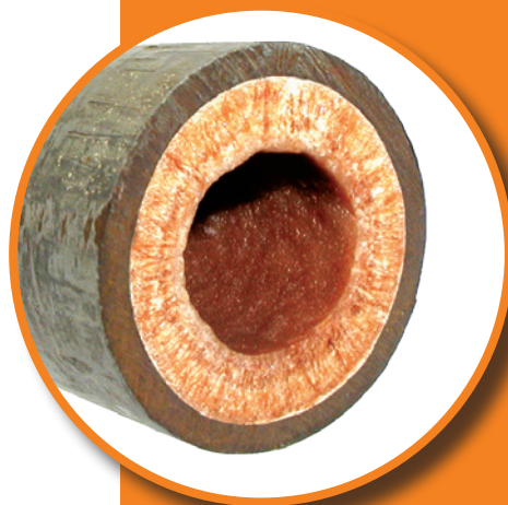
Kalkablagerungen an einer Rohrleitung
