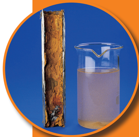
Korrosion an Rohrleitungen
