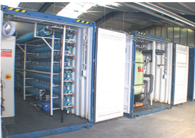
Produktion von Containeranlagen
