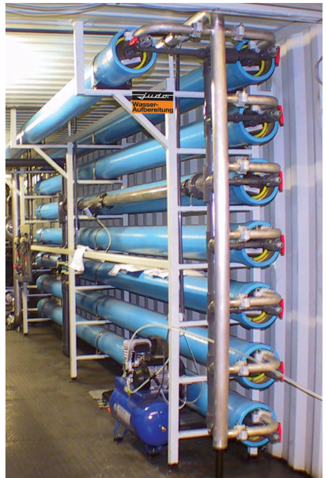
Membranrack Meerwasserentsalzanlage
