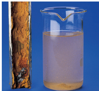
Lochfraß, Rost und braunes Wasser in einer nicht geschützten Anlage.
