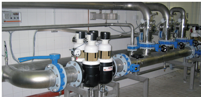
Einbaubeispiel PROFIMAT-ATP DN 200
