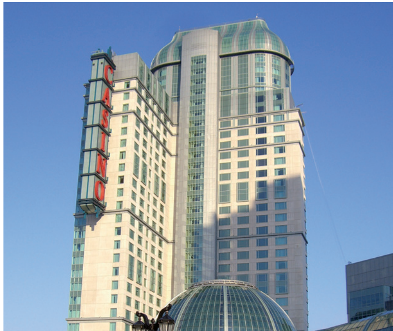
Einbaubeispiel PROFIMAT-ATP DN 200 im Hotel und Casinokomplex „Niagara Fallsview“ in Kanada
